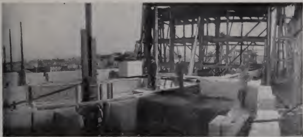
279. — Lo stibolate in costruzione
